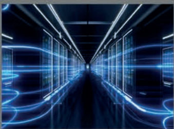
SOLUCIONES DE DATA CENTER
