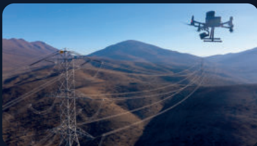
INSPECCIÓN CON DRONES
